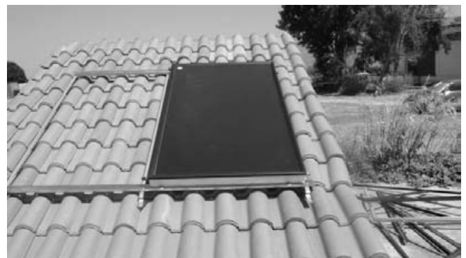
Figure 11 – Pose d'un capteur sur un support pour 2 capteurs
