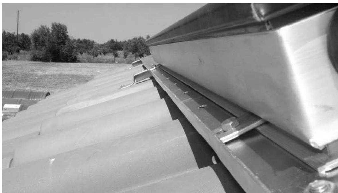
Figure 13 – Mode d'insertion des plaquettes de fixation sur le capteur
