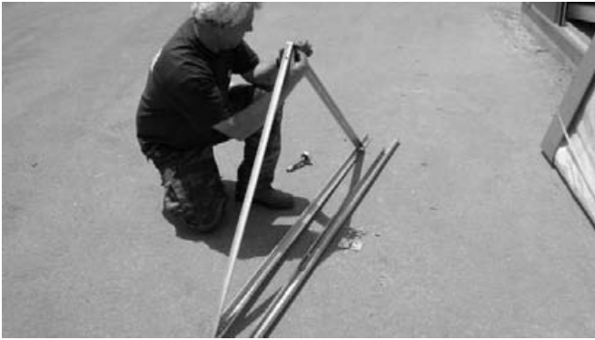
Figure 15 – Mise en place des barres de supportage
