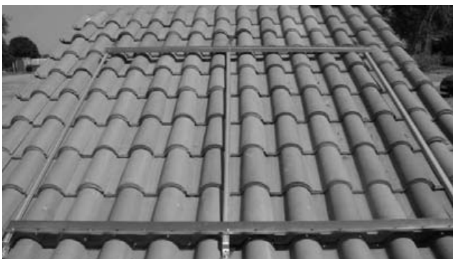
Figure 10 – Pose d'un support pour 2 capteurs sur le toit
