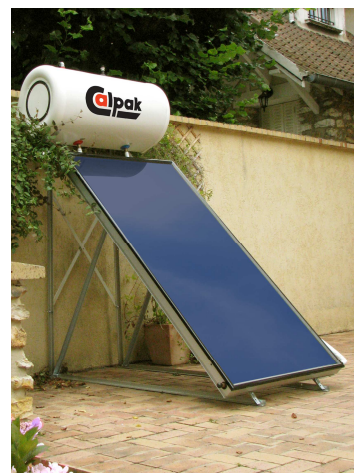
Chauffe-eau solaire installé
